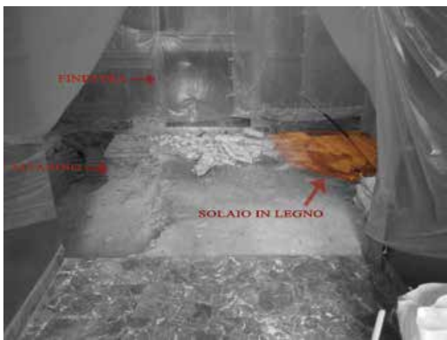
Figura 5 - Rimozione del solaio ligneo
