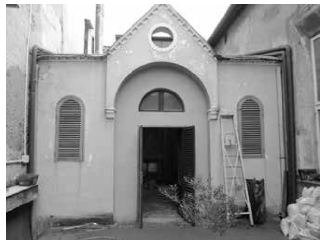
Figura 2 - Ingresso principale alla Biblioteca
