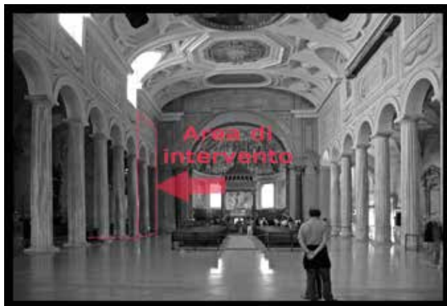
Figura 1 - Vista dall'interno con evidenziata l'area di intervento
