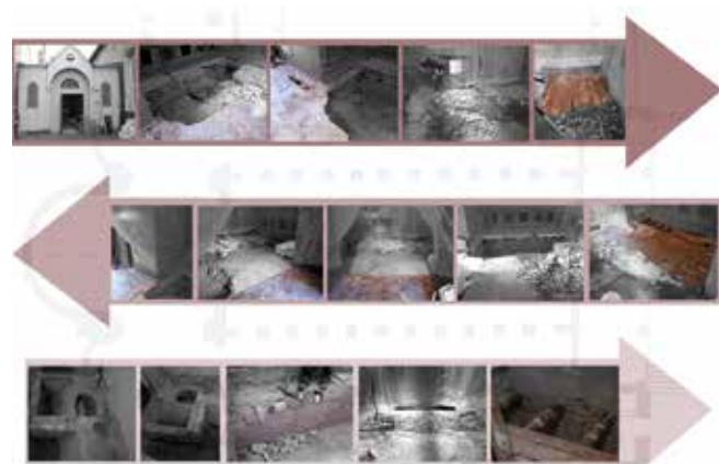
Figura 3 - Fasi di demolizione della pavimentazione preesistente con gli elementi architettonici rinvenuti
