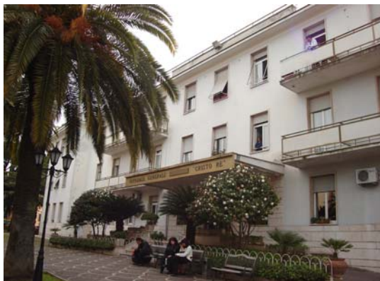
Vista del corpo di fabbrica oggetto di verifica
