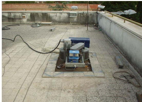
Dettaglio di installazione della vibrodina sul piano di copertura
